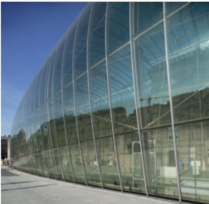
看起来就如同“橱窗展示”。这种复杂的设计既保留了这座铁路建筑的传统风格，又符合泛欧化的审美标准。德国的一家立面建造商赢得该项目后，又将金属结构框架的组件生产分包给一家波兰的制造商。建筑师通过使用低辐射夹层玻璃和一种渐变的丝质帘幕调整室内的温度。这些玻璃板和屏幕板外侧是白色的，内侧是黑色的。优化了屋顶结构以符合该地区的抗震要求，利用了热弯玻璃的弯度和硬度特质。
