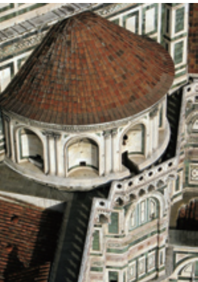
大教堂耳室顶部
