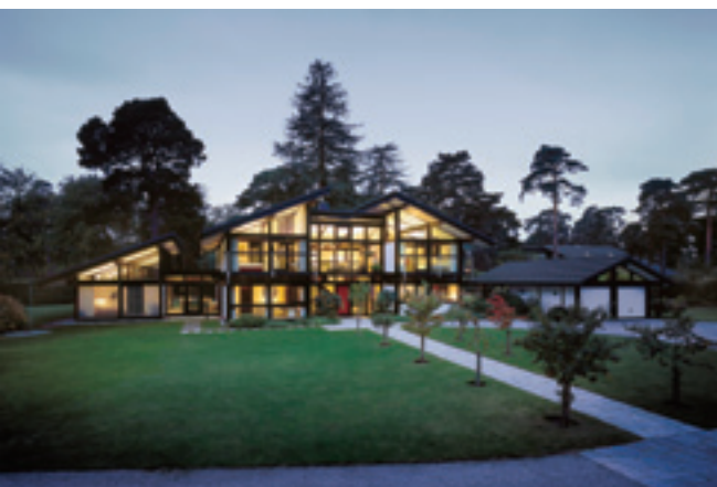
木构桁架建筑能够很好地融入大自然风景之中
