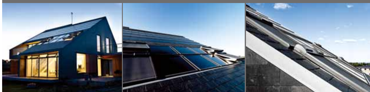
屋顶太阳能动力窗及室外遮阳帘
