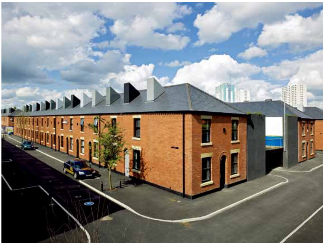
图1 与早期建筑中比比皆是、象征着温馨家庭生活的烟囱不同，日前在英格兰北部的重建排屋中，烟囱充当了创意独特的采光井，这一新的角色，使阳光可以直接照射到建筑物内部。
