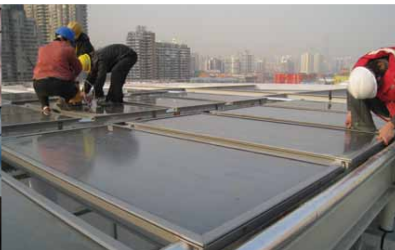
图11 太阳能热水系统施工过程
