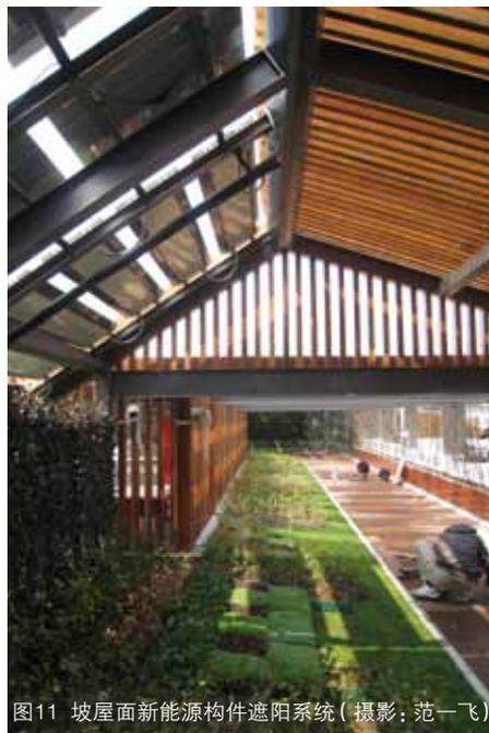
图11 坡屋面新能源构件遮阳系统 (摄影: 范一飞)
