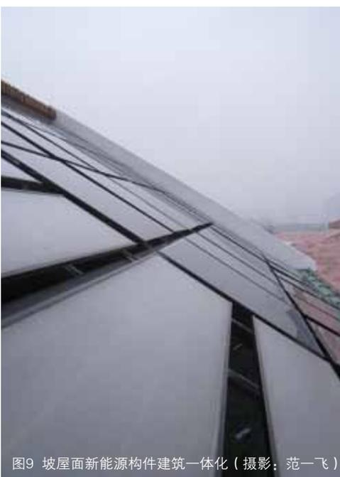
图9 坡屋面新能源构件建筑一体化 (摄影: 范一飞)
