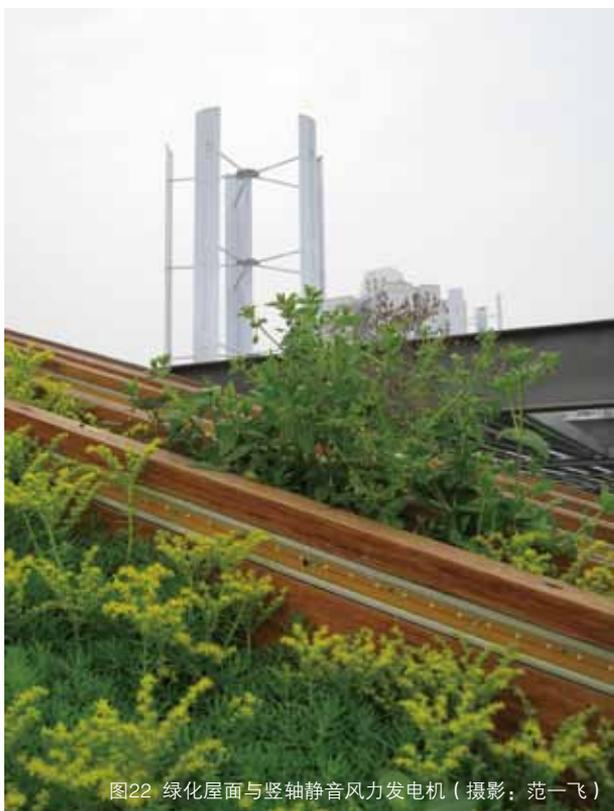
图22 绿化屋面与竖轴静音风力发电机 (摄影: 范一飞)
