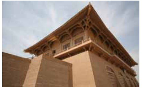
大明宫中装饰混凝土轻型墙板应用
