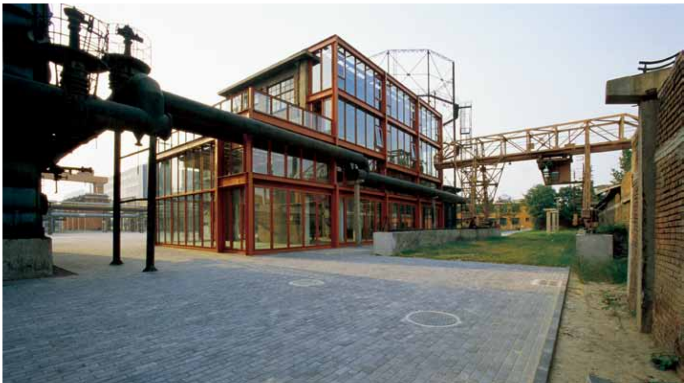
751项目中改造后的老炉区
