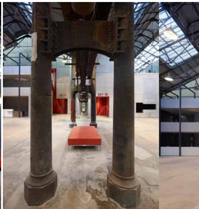
保留原有建筑严谨的柱网结构（摄影：Michael Nicholson）
