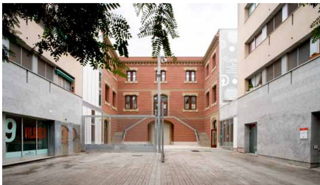
改造后建筑立面
