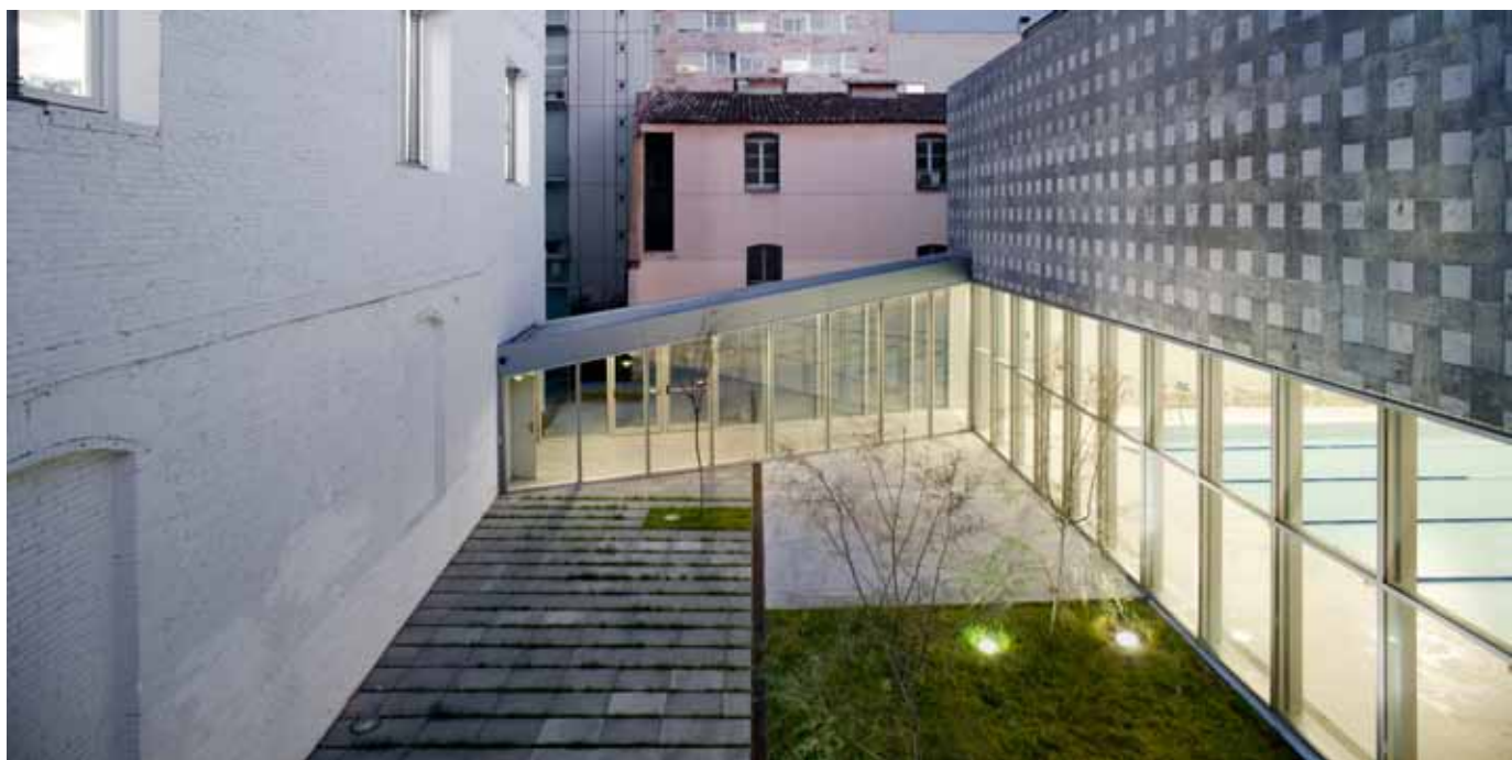
新旧建筑之间的连廊和庭院
