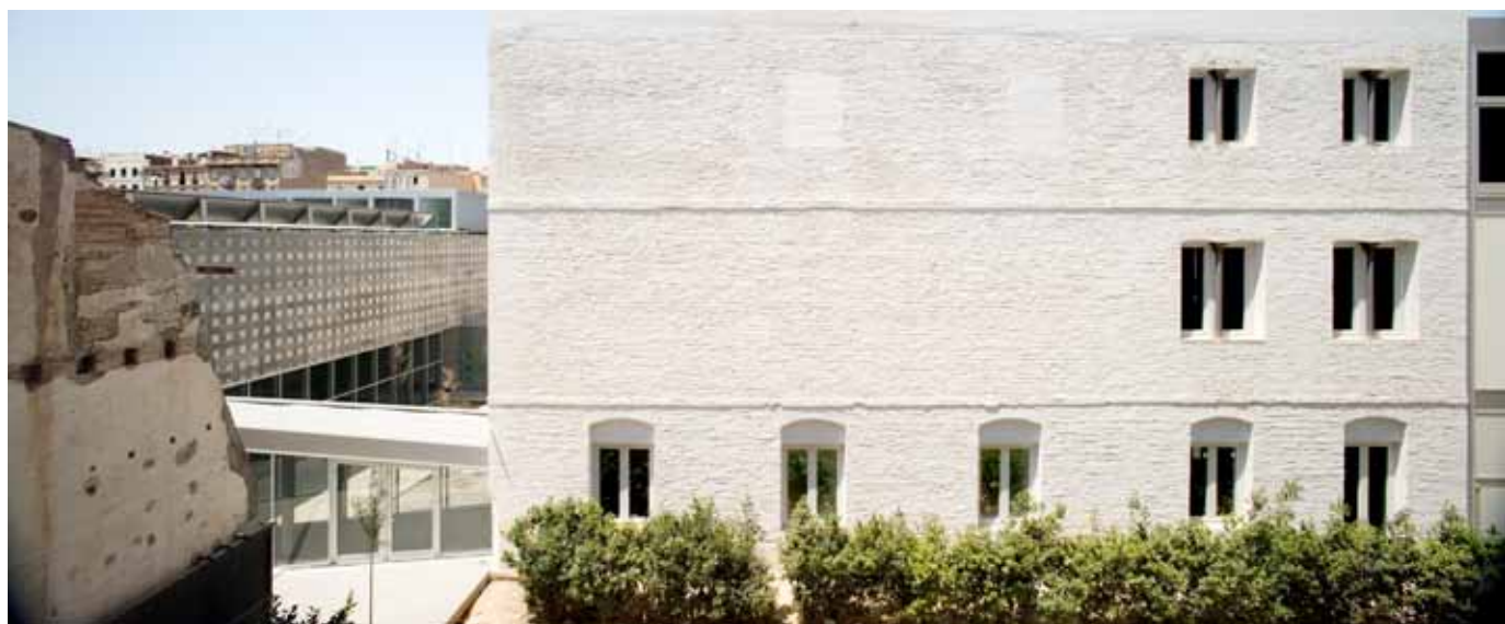
改造后恢复建筑抹灰墙面
