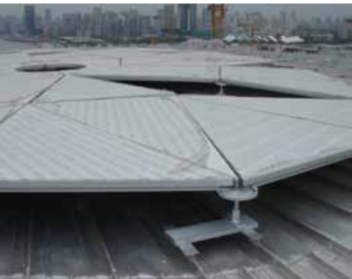
上壳幕墙安装现场
