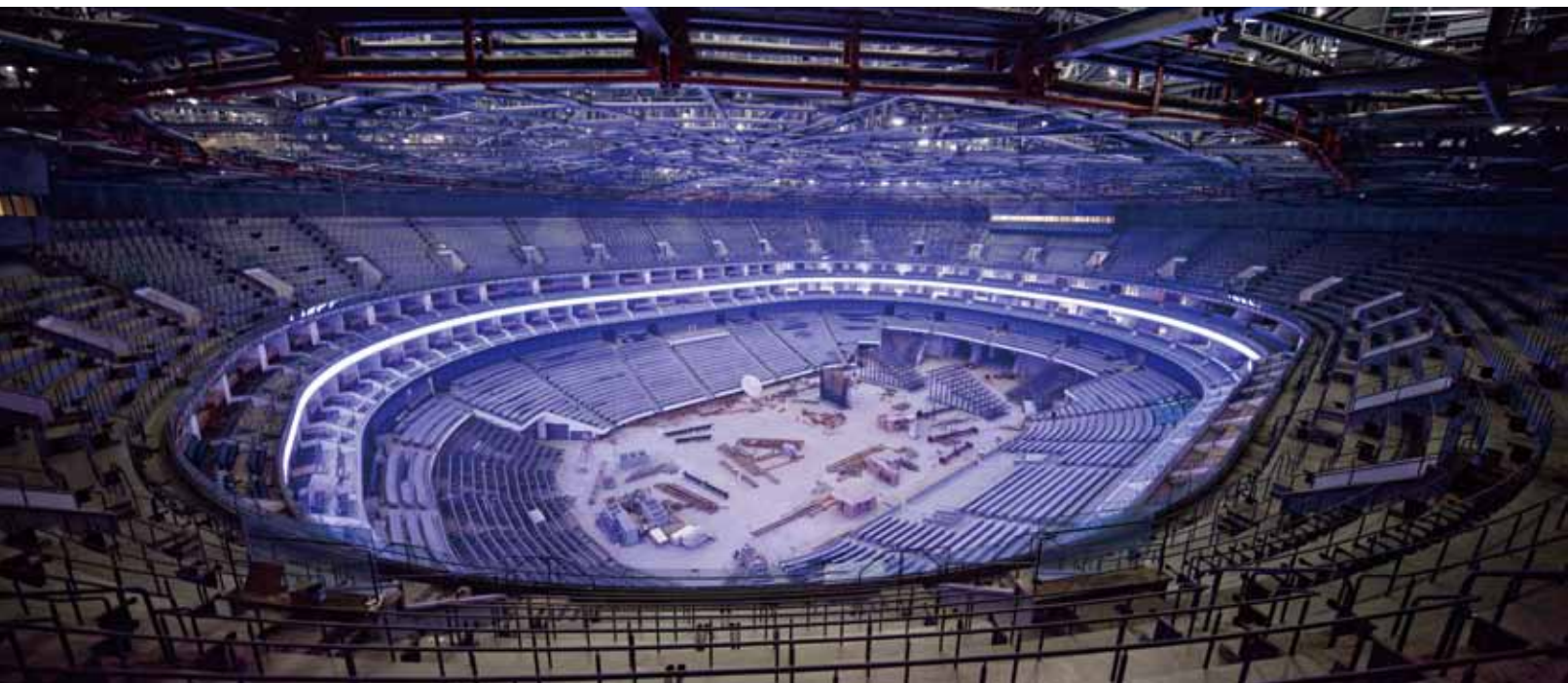
建设中的世博文化中心主场馆（摄影：邵峰）
