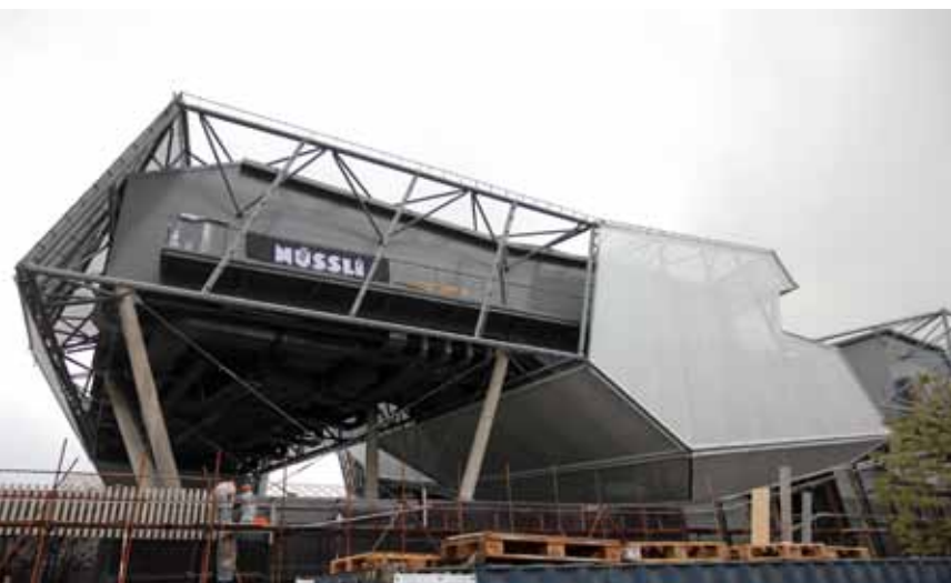
次结构与表面膜材的安装（摄影：吴吉明）
