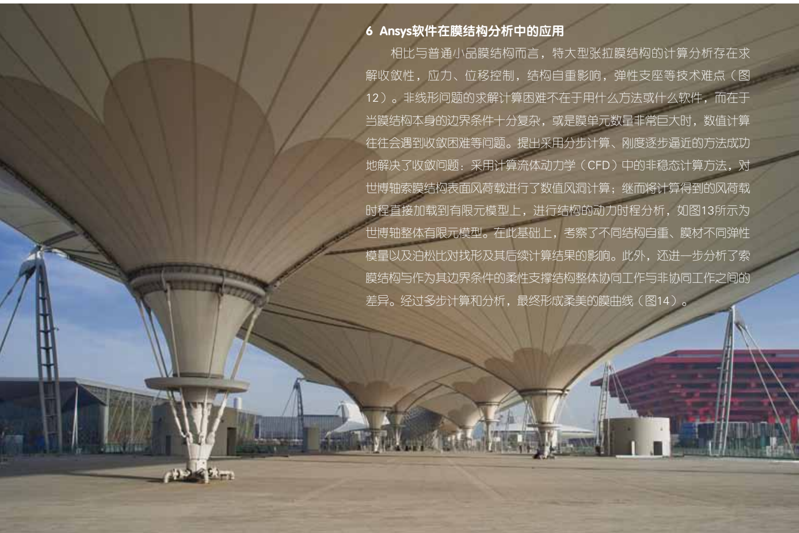
图14 张拉索膜的基部
