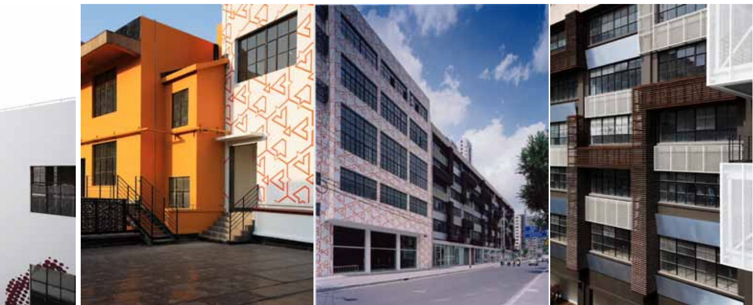
改造后建筑立面
