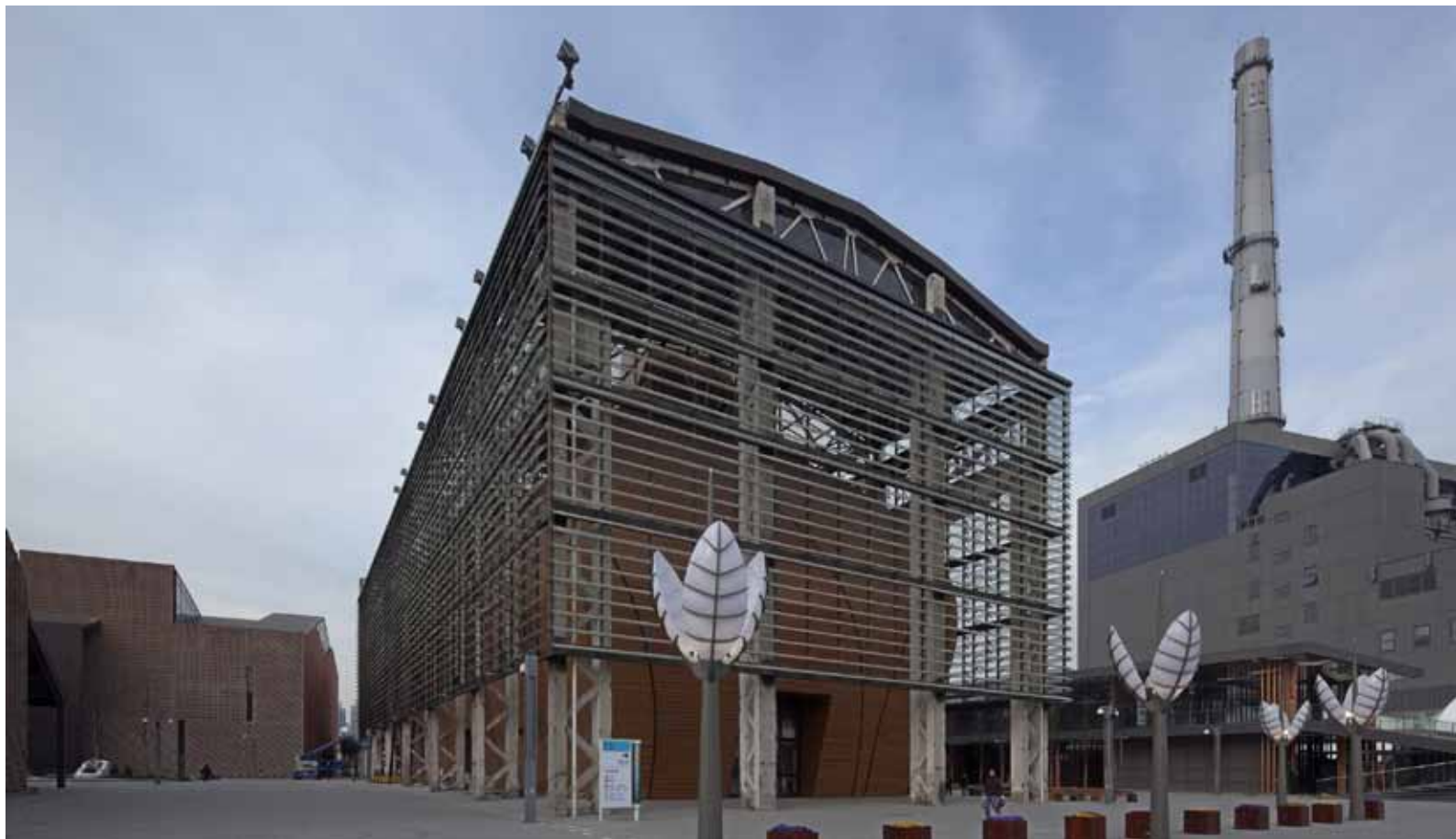
图22 改造后建筑外观
