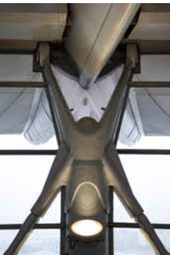
外柱铸钢节点的实体照片
