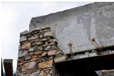
图7 派镇酒店施工现状
