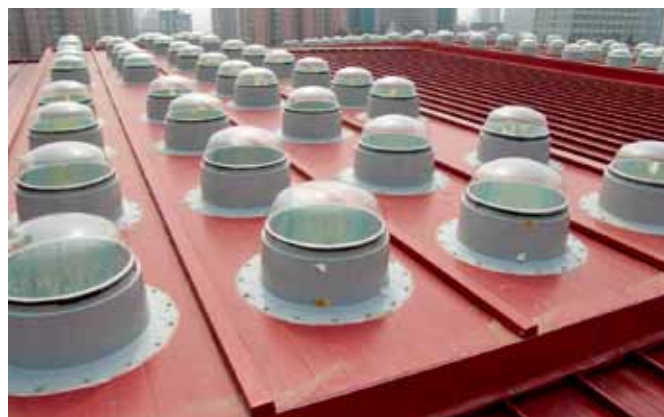
柔道跆拳道馆屋面148只光导管的集光器(摄影栗铁)（庄惟敏主持设计）
