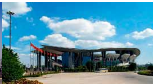
第十二届全国运动会沈阳五里河体育中心主体育场
