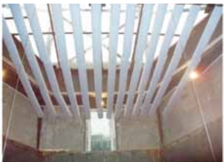
图10 屋盖吸声体悬挂示意
