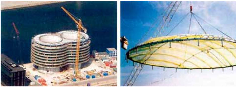
图4 Frosilo Flats住宅楼吊装中的气枕式膜结构顶棚
