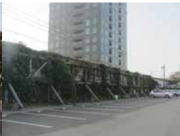
图8 旧墙加固成停车场
