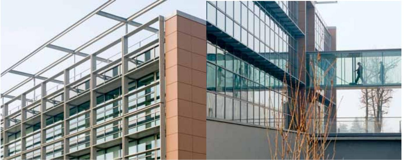
体系，为办公空间提供适宜的光线。B楼的主要功能为实验室和生命科学部，其特点在于使用透明的聚碳酸酯做建筑表皮，同时其色彩和透明度可根据外部气候环境的变化而不同。当然阳光也可透过聚碳酸酯表皮照亮室内，解决室内光照要求和整体热工性能。C楼主要用于产业部应用研究，其功能的优化要归功于平板的加固、屋顶的修复与外部隔绝幕墙的运用。
