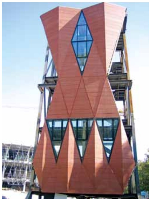
图4 幕墙单元样板墙。
