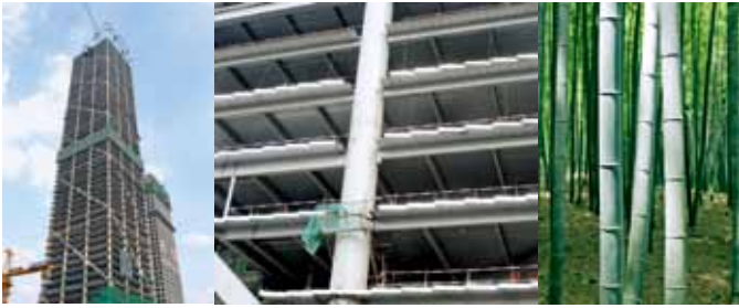
图4 钢管混凝土柱模拟大自然（资料来源：Paul Vlaar，聚焦照片：MKA）
