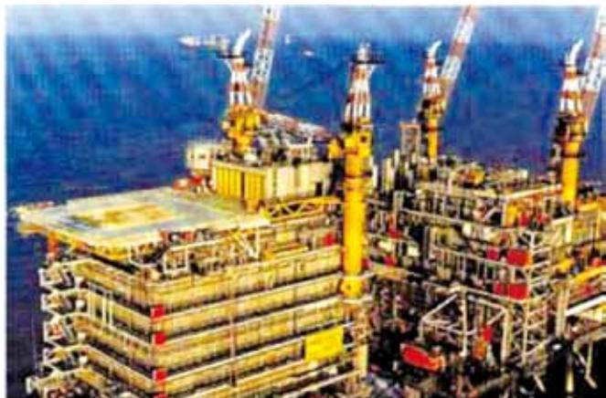
图1 英国莫克姆湾的这座天然气平台采用不锈钢包覆层来确保平台的长期无故障运行（照片由英国天然气公司提供）
