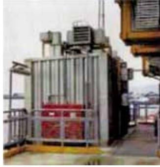
图9 不锈钢压型板包覆层制造的防火墙 ( Darchem 公司提供 )
