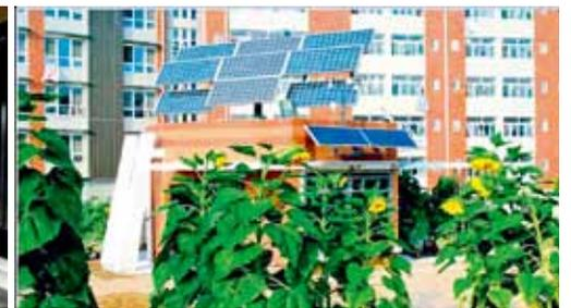
图15 高效精确追踪式太阳能光伏发电系统
