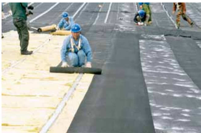
图10 保温棉及卷材铺设
