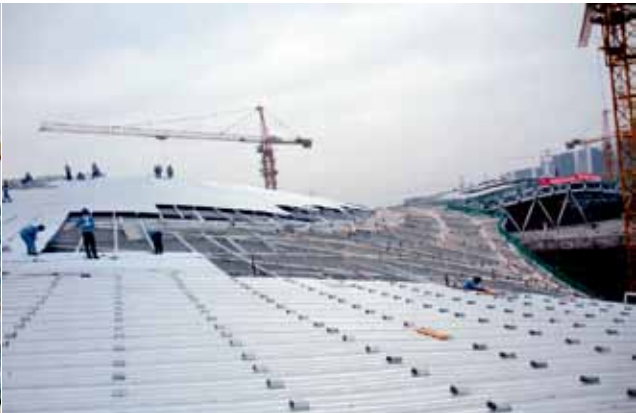
图9 钢底板及衬檩支撑安装
