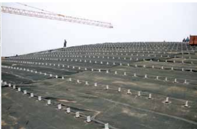
图11 屋面板固定座安装
