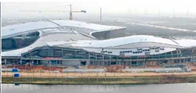
图15 不锈钢装饰板铺
