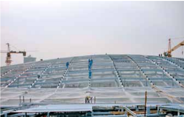
图8 檩托、檩条安装
