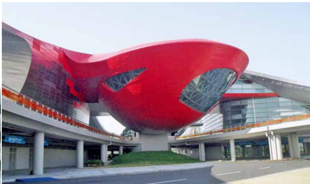
图17 不锈钢板幕墙安装后现场照片
