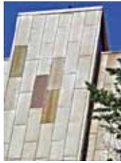
图6 教堂的镀锌钢屋顶板发生腐蚀
