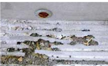
图3 除冰盐造成铝制门槛发生严重腐蚀
