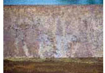
图8 一幢大楼外部的耐候钢材遭受除冰盐破坏
