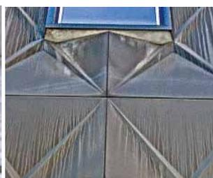
图4 一幢办公楼第二层的阳极氧化铝板遭受除冰盐腐蚀
