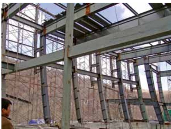
竖向钢结构施工
