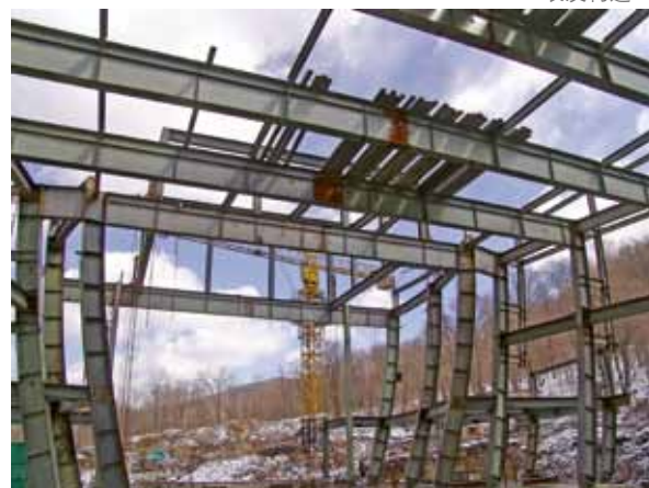
横向钢结构施工
