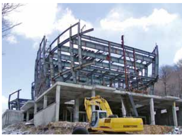
总体钢结构完成
