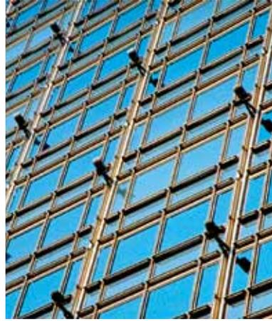
长江中心的幕墙窗槛墙上下各有一条不锈钢装饰构件，且每个幕墙单元由四个不同单元组成
