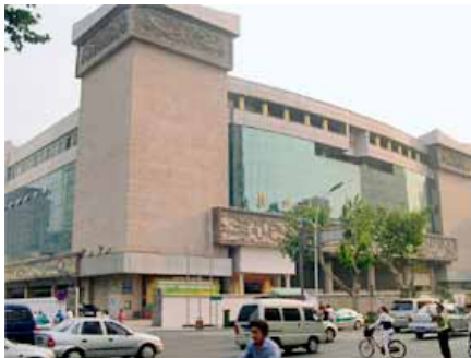
图2 改造前建筑外观
