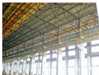
图7 改造前厂房内部
