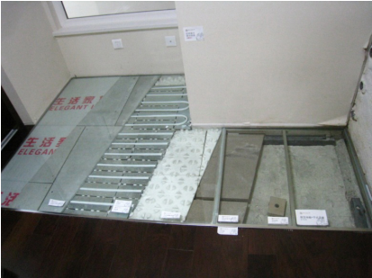
图11 住宅管线与墙体分离的技术
