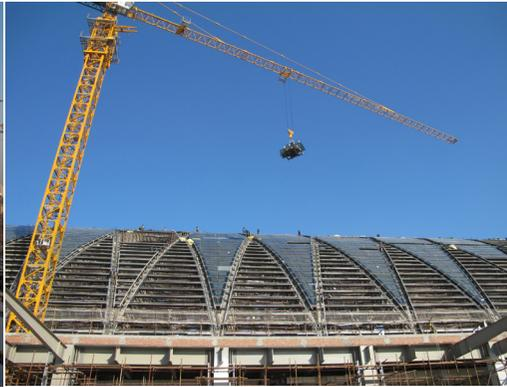
图23 拱顶侧面玻璃安装
