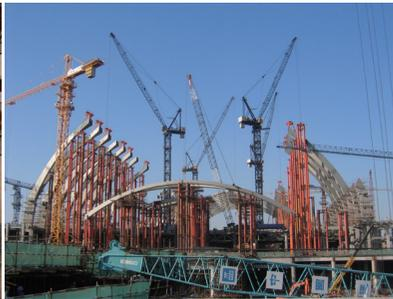
图9 拱顶钢结构分段提升
