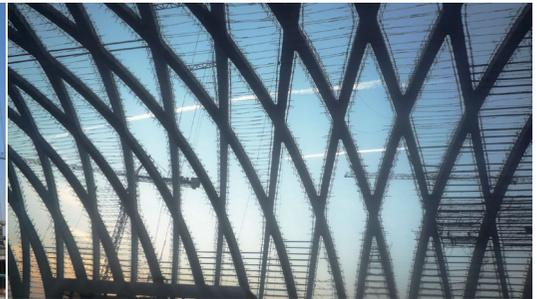
图10 拱顶钢结构施工阶段内部效果
