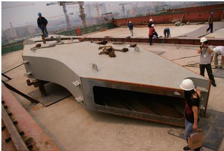
图8 拱顶钢结构构件
