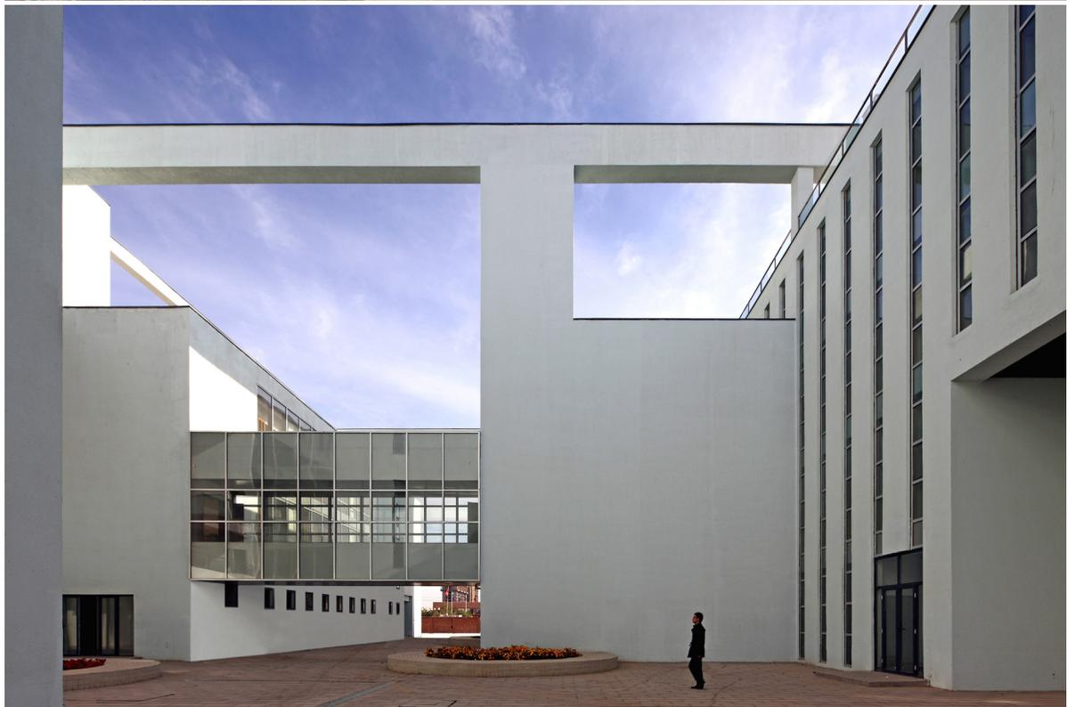
心、人民教育基金会、教育会计中心、学生资助中心、职业教育中心、普通话测试中心等十几个不同的单位；培训及生活服务包括客房、餐厅、健身、室外球场等。这些功能包含了工作、学习、娱乐、吃、住等等，如何解决多种功能空间的流线关系及塑造整体形象是设计的重点。在运用模型块的方式分析后，我们决定采用 $8.4\text{m} \times 8.4\text{m}$ 的网格控制整体建筑布局，将不同的空间统一在整体的立方体中，外部塑造完整的建筑形象，内部院落式的格局使得所有的主体空间相对独立，并且均能自然采光通风，减少设备系统安装及运行的投入，起到了被动式节能的作用。另外，各个部门的建筑均
