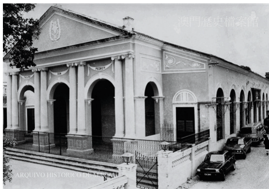
岗顶剧院照片
