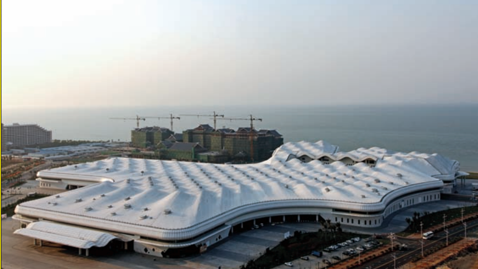
东南方向俯瞰会展中心
