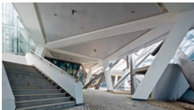
由结构师建议的外露三角形梁格与斜方柱被建筑师采纳
