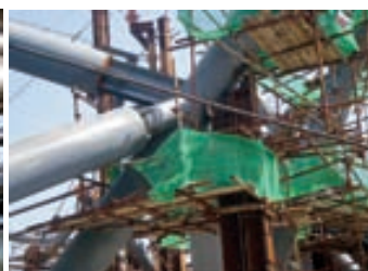
缩径转换焊接节点
