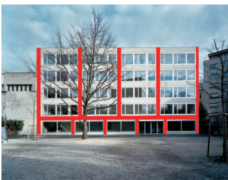
图2 建筑立面上下实体墙不对位
