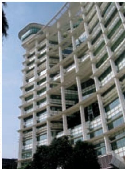
图12 新加坡国立图书馆外墙遮阳
