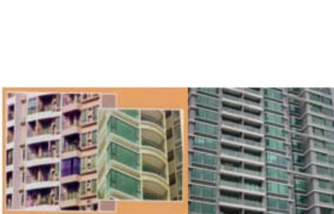
图8 常见的普通单层玻璃窗、玻璃幕墙的设计，无任何遮阳
