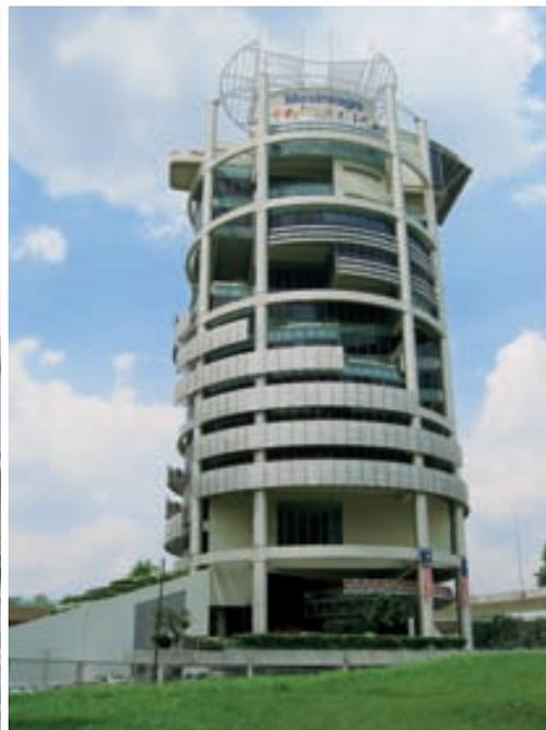
图16 马来西亚梅纳拉大厦大进深的凹进玻璃窗与外遮阳挡板
