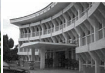
图17 台湾地区某高中导风板与遮阳所塑造的湿热气候建筑美学<sup>[3]</sup>
