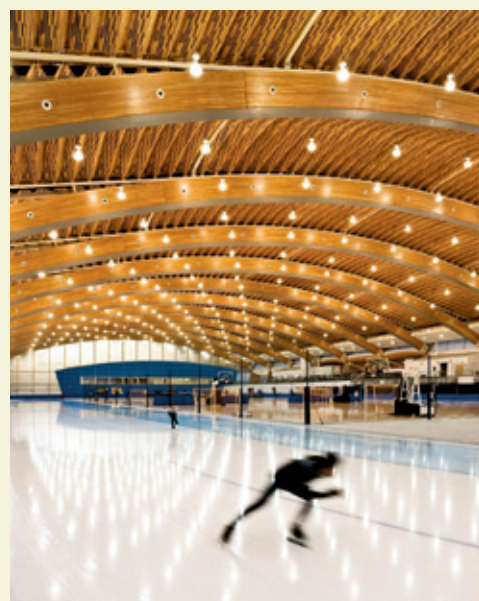
冬奥会速滑馆室内
