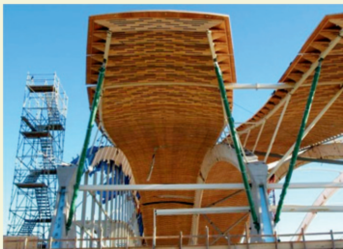
冬奥会速滑馆屋顶
