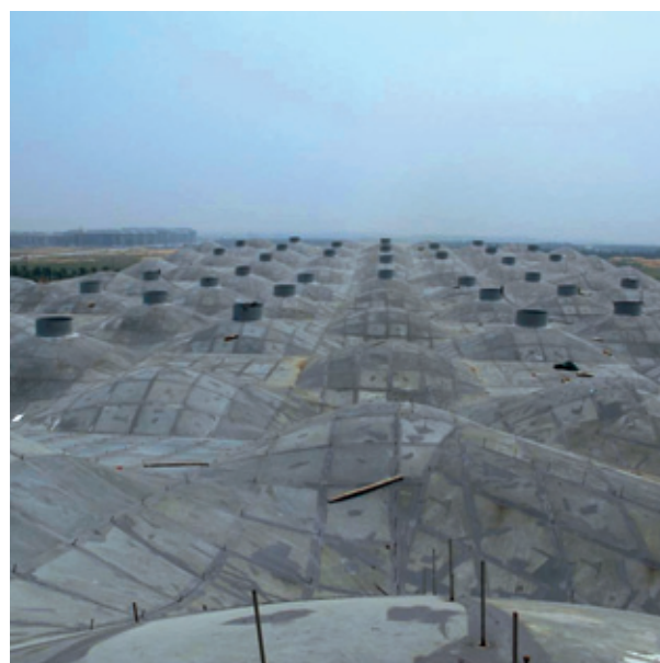
建设中的海南国际会展中心起伏的屋面
