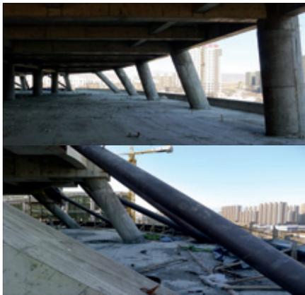
图11 主体结构采用斜柱方案
