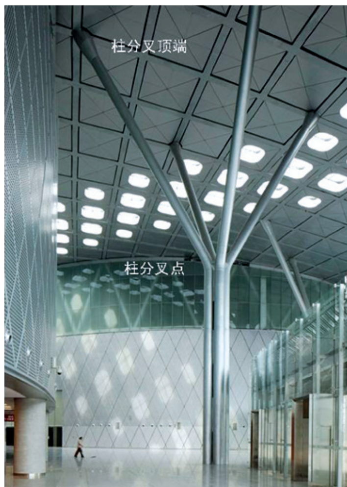
图10 树状柱分叉及顶端示意图
