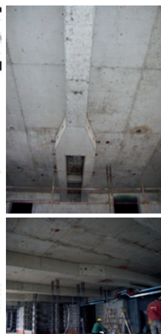
图21c 竣工的叉形梁
