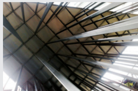
图4 屋顶底侧视图
