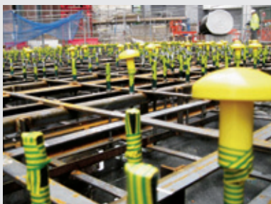
图6 混凝土浇筑前的螺栓笼
