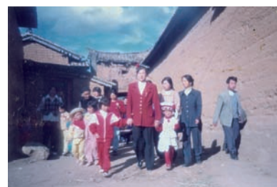
南寨门拆除前
