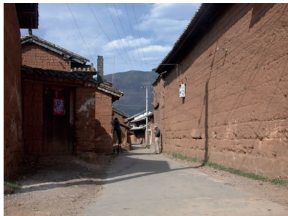
南寨门拆除后
