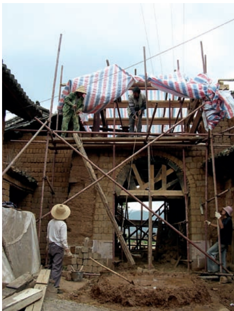
砌筑南寨门墙体
