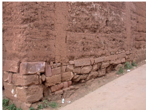
南寨门拆除后残留的侧墙
