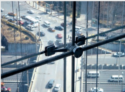
图6 不锈钢缆与玻璃之间的连接
