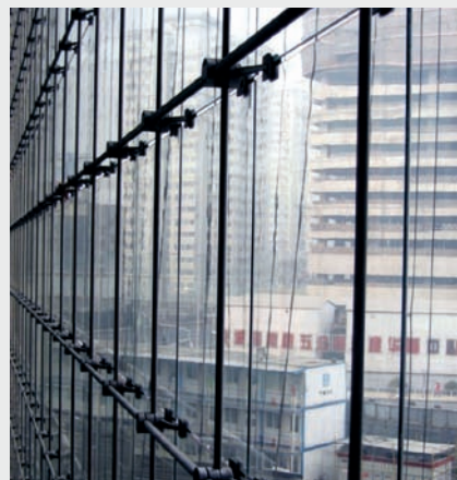
图3 索网部件照片，包括支撑加固部分
