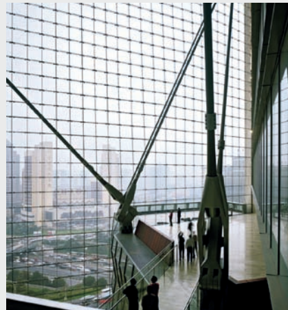
图2 主索网玻璃幕墙及其主要的V形钢缆
