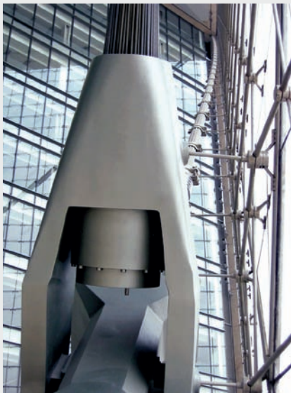
图7 与不锈钢缆相连接的铸钢机械摇摆装置
