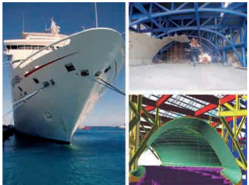
图4 使用造船技术的钢表皮
