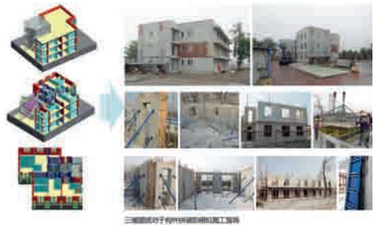
图16 “三维图纸”通过构件拼装模拟施工
